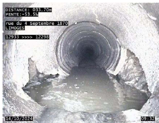
Figure 28 : Effondrement sur le tronçon 12933-12298
