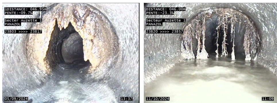
Figure 14 : exemple d'anomalie observé lors des ITV sur le secteur d'Auzette : Concrétion (à gauche) et racines (à droite)
