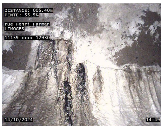
Figure 27 : Suintement sur le tronçon 11159-12930
