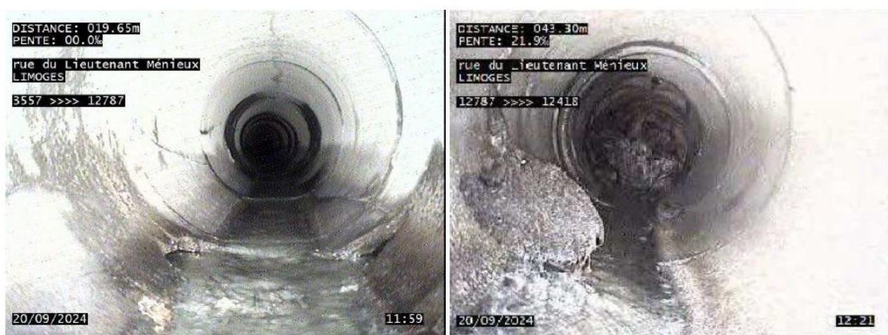
Figure 20 : Exemple d'effondrement avec exfiltration (à gauche) et de racine (à droite) observé lors des ITV
