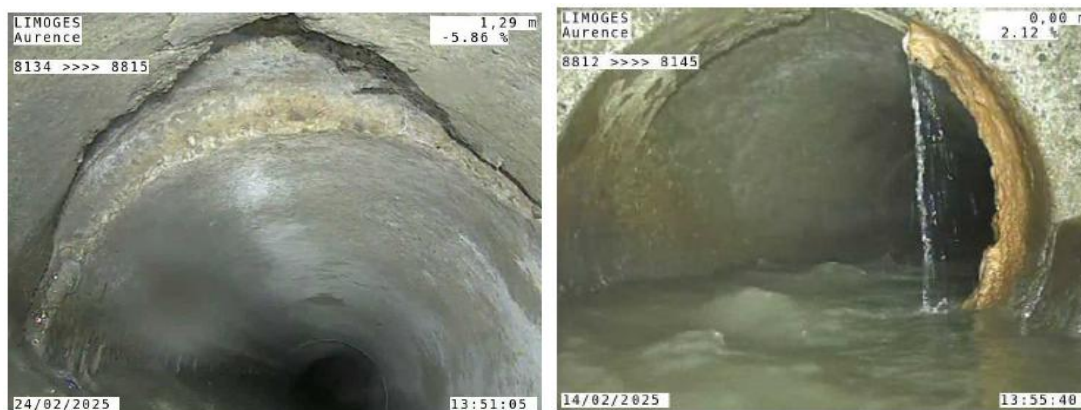
Figure 6 : Exemple de dégradation de surface (à gauche) et d'infiltration (à droite) observé lors de l'inspection
