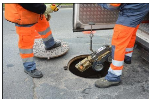
Figure 2 : Principe et matériel utilisé lors des ITV
