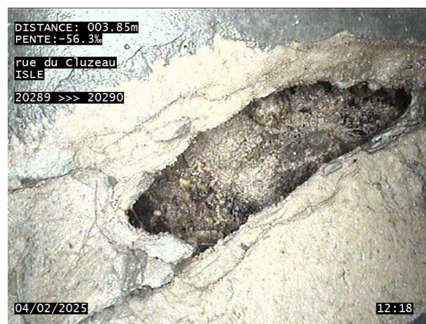
Figure 33 : Dégradation de surface sur le tronçon 20289-20290
