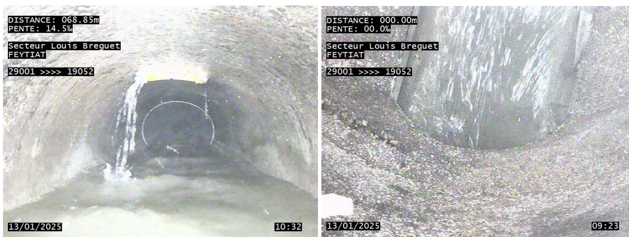
Figure 36 : Exemple d'anomalie observée : écoulement d'eau clair par un branchement(à droite) et dégradation de surface (à gauche)
