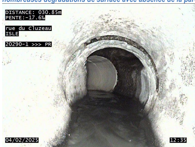
Figure 32 : Effondrements sur le tronçon 2090-1-PR
